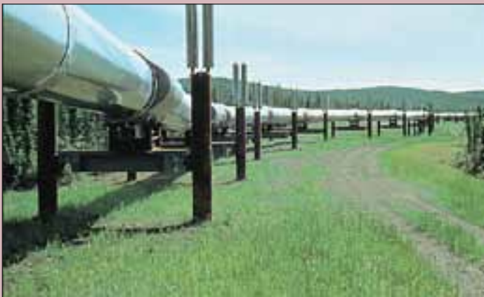
Des piliers soutiennent les sections de l'oléoduc trans-Alaska afin qu'il ne soit pas touché par le pergélisol.
